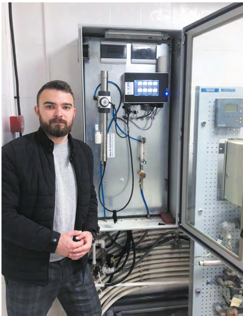
Автоматизированная система онлайн-контроля качества воды питьевого водоснабжения, участником внедрения которой был магистр кафедры К. Столбов
